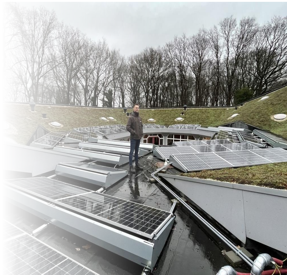
Hovenier Martijn Buld op het groene dak van gezondheidscentrum Thijinge in Zuidwolde.
