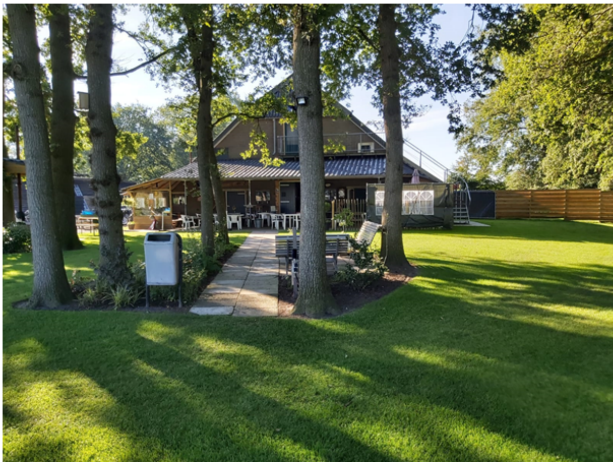
Afbeelding 3: De vooraanblik van het gebouw met entree van de douches/ toiletten/ B&B en de kantine.
