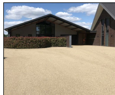
Figuur 34 Asfalt met natuurlijke slijtlaag
