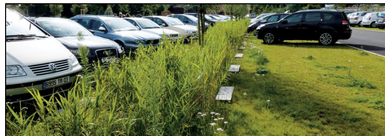
Figuur 39 Halfverharde en met grasbeton verharde parkeerplaatsen
