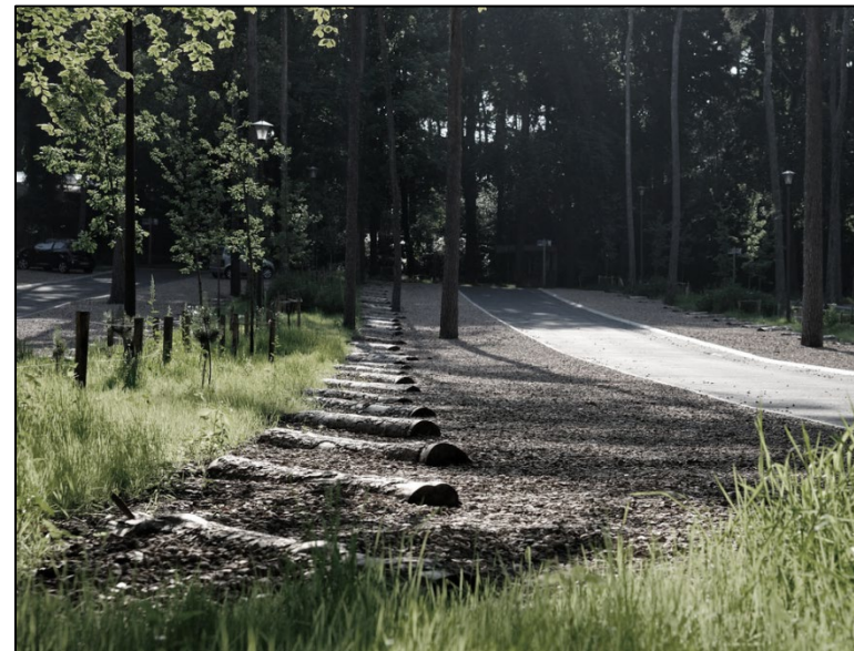
Figuur 38 Halfverharde parkeerplaats met boomstammen als stootblokken, langs de weg (visserslodges)
